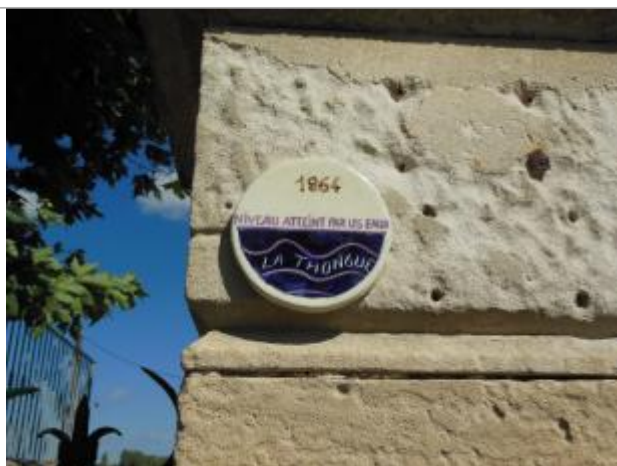
repère sur pillier
