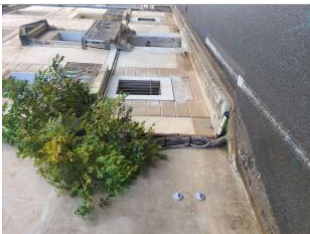
Repères de crue posés sur la façade du n°20 de l'avenue
