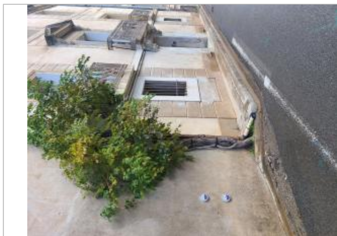
Repères de crue posés sur la façade du n°20
