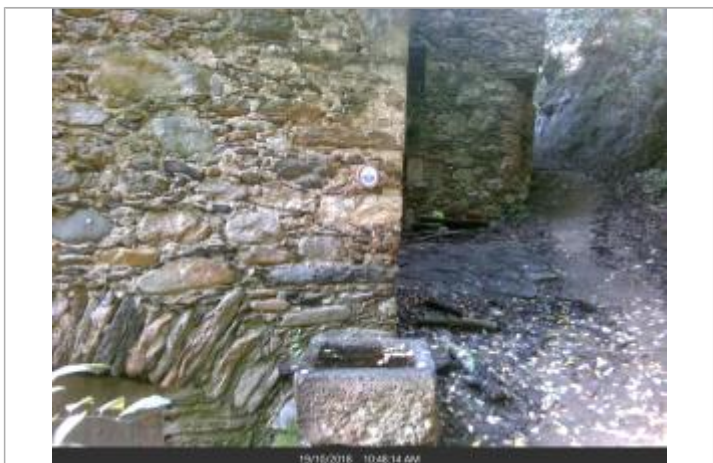
Repère de crue de 1953 à l'angle en bas du moulin
