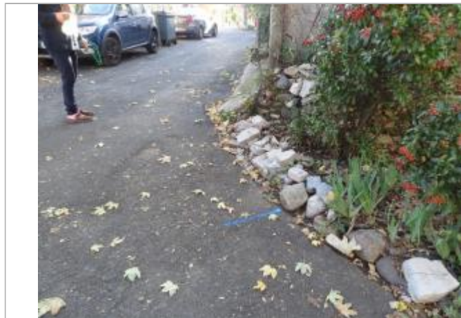
laisse au sol au niveau du 2 rue des tanneurs
