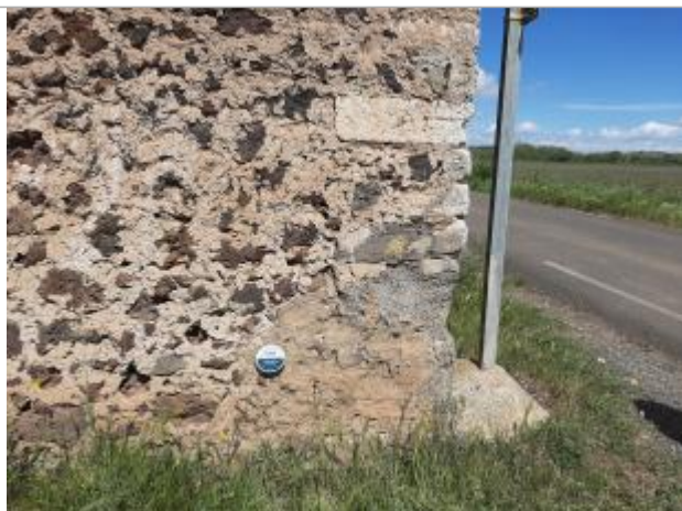
repere dans coin du bâtiment.
