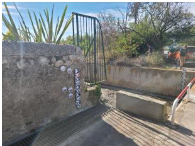
Repères posés sur le mur en rive gauche
