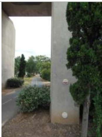
vue des repères sur pile de pont
