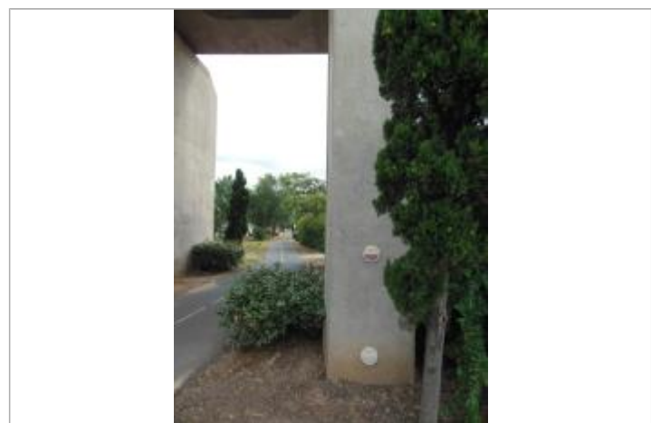
vue des repères sur pile de pont
