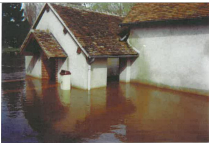
Site pendant la crue (photo recensement d'origine)
