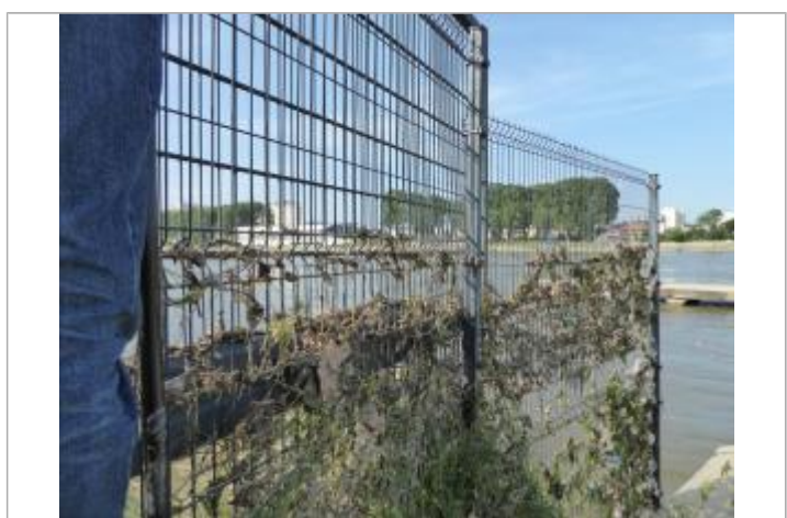
Vue du repère - Auteur : SCHAPI
