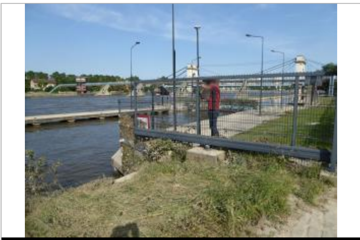
Vue du site - Auteur : SCHAPI
