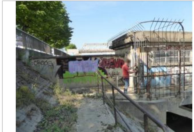
Vue du site - Auteur : SCHAPI
