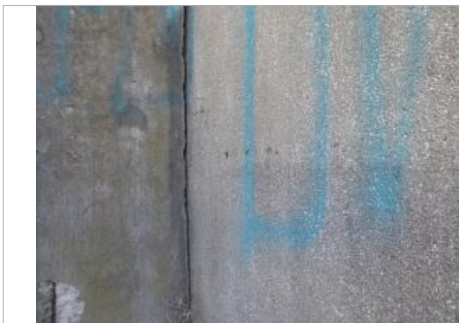
Vue du repère - Auteur : SCHAPI
