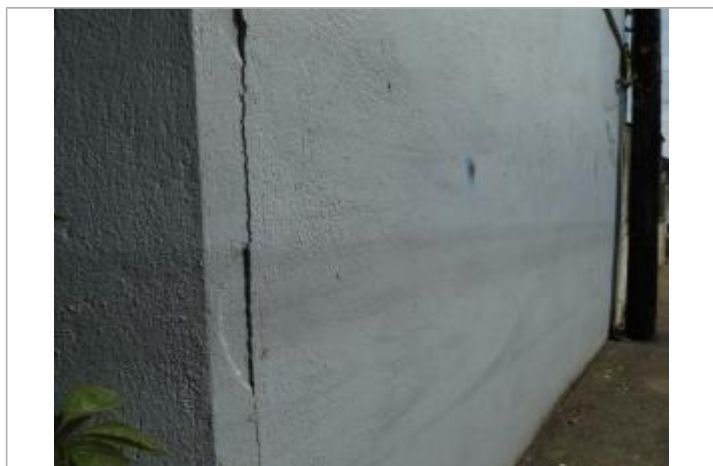
Vue du repère - Auteur : SCHAPI
