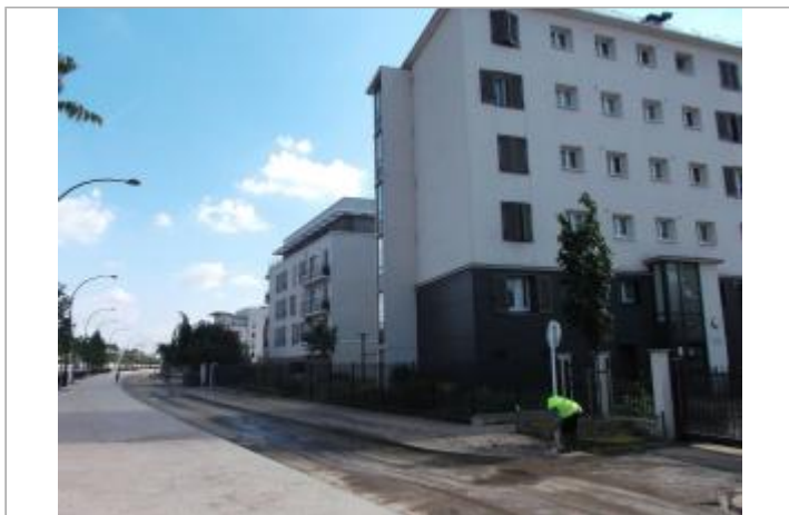
Vue du site - Auteur : DRIEE IDF
