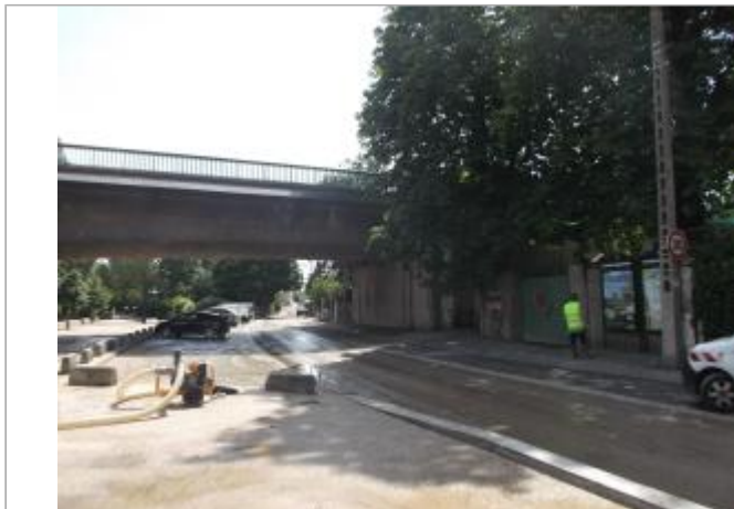
Vue du site - Auteur : DRIEE IDF
