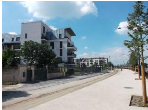
Vue du site - Auteur : DRIEE IDF
