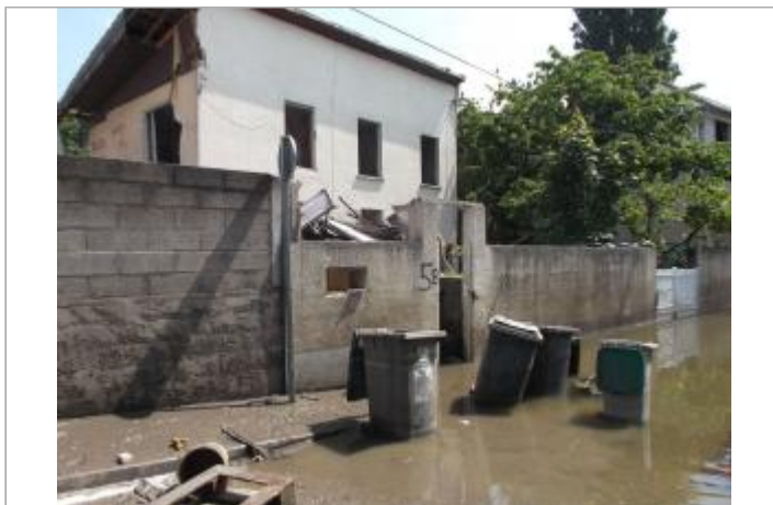
Vue du site - Auteur : DRIEE IDF
