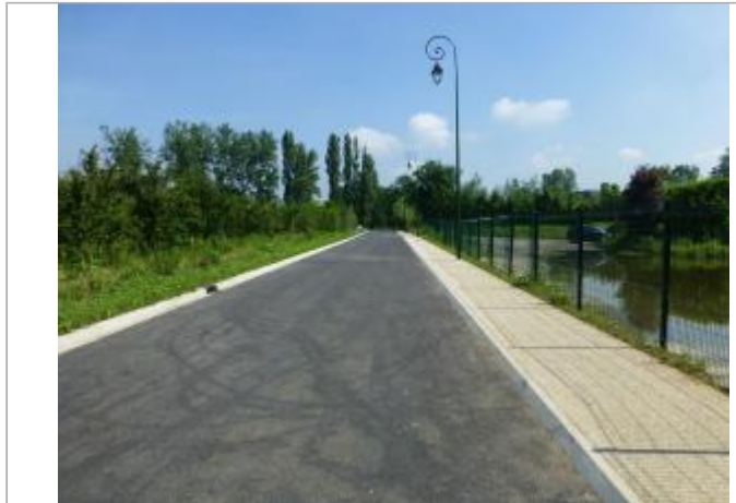
Vue du site - Auteur : DRIEE IDF
