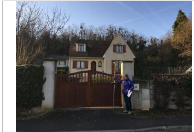
Vue du site - Auteur : DRIEE IDF
