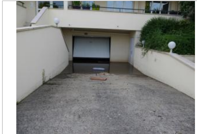
Vue du site - Auteur : DRIEE IDF
