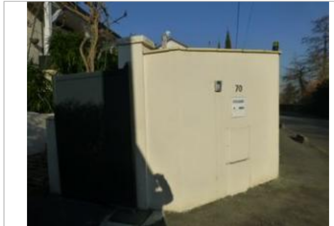
Vue du site - Auteur : DRIEE IDF
