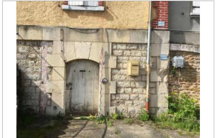
Vue du site - Auteur : DRIEE IDF
