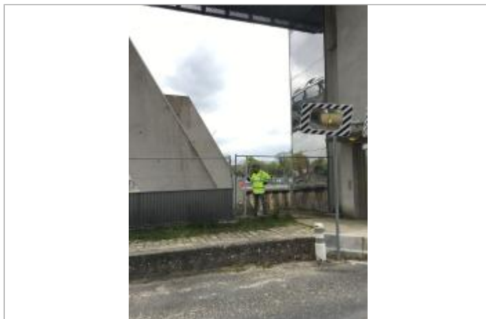
Vue du site - Auteur : DRIEE IDF
