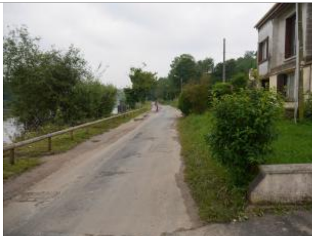
Vue du site - Auteur : DRIEE IDF
