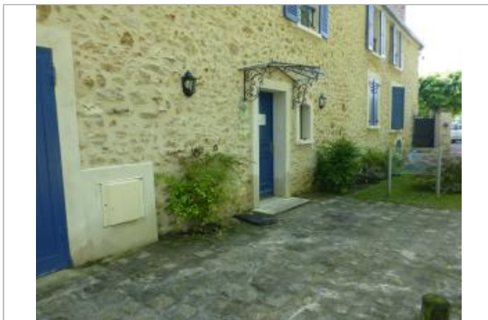
Vue du site - Auteur : DRIEE IDF
