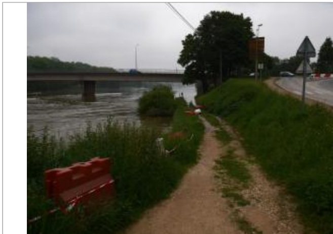
Vue du site - Auteur : DRIEE IDF
