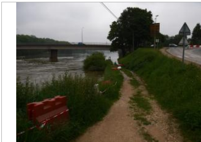
Vue du site - Auteur : DRIEE IDF
