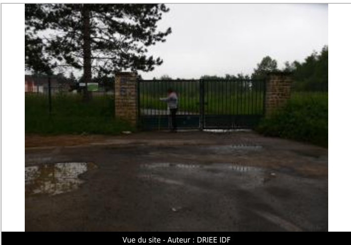
Vue du site - Auteur : DRIEE IDF
