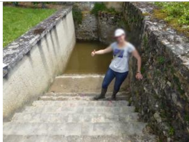
Vue du site - Auteur : DRIEE IDF
