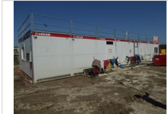
Vue du site - Auteur : SCHAPI
