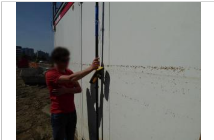
Vue du repère - Auteur : SCHAPI
