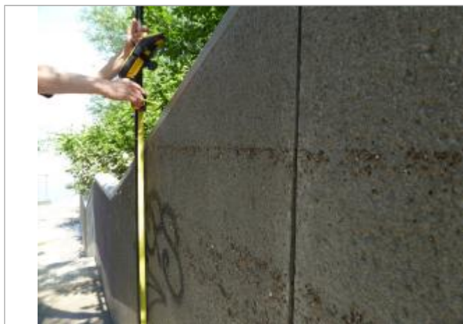
Vue du repère - Auteur : SCHAPI
