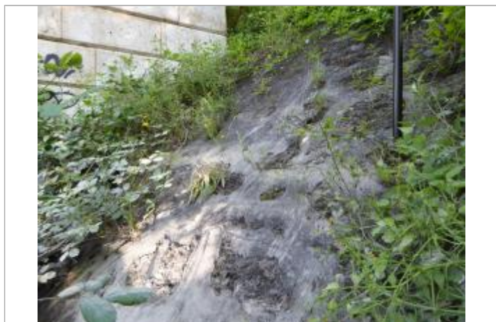
Vue du repère - Auteur : SCHAPI
