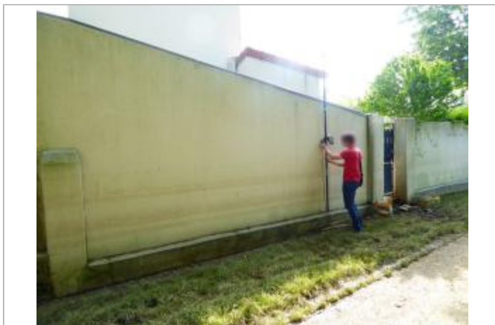
Vue du site - Auteur : SCHAPI
