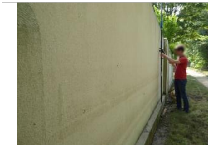
Vue du repère - Auteur : SCHAPI
