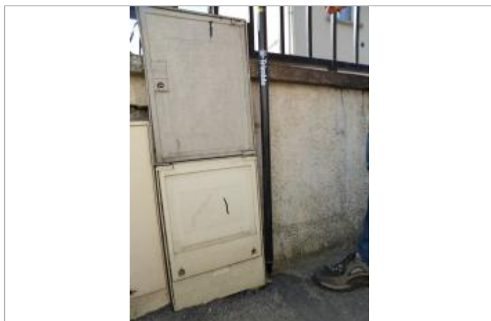
Vue du repère - Auteur : SCHAPI
