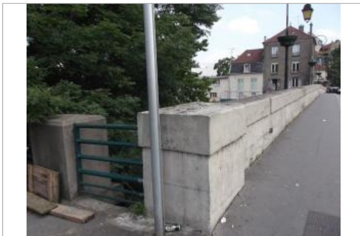
Vue du site - Auteur : DRIEE IDF
