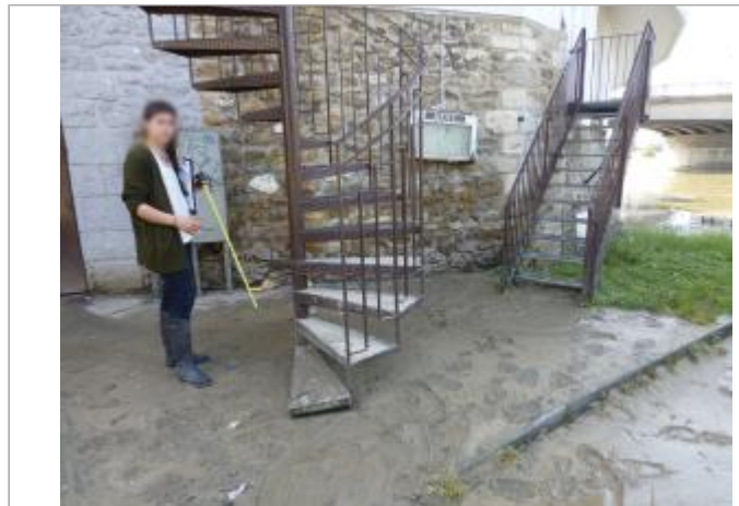
Vue du site - Auteur : DRIEE IDF
