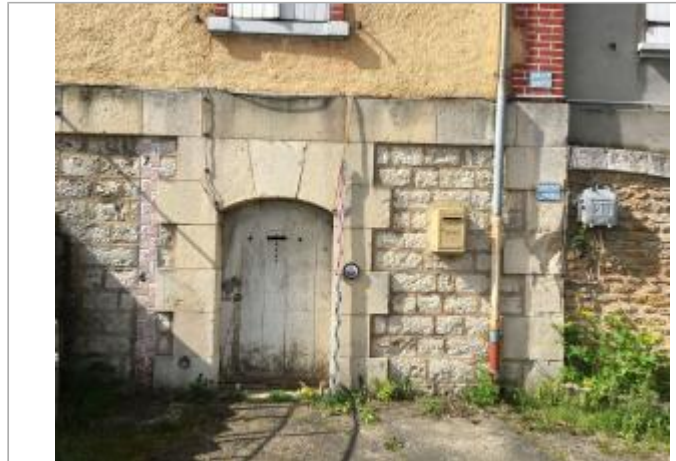
Vue du site - Auteur : DRIEE IDF
