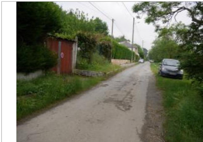
Vue du site - Auteur : DRIEE IDF
