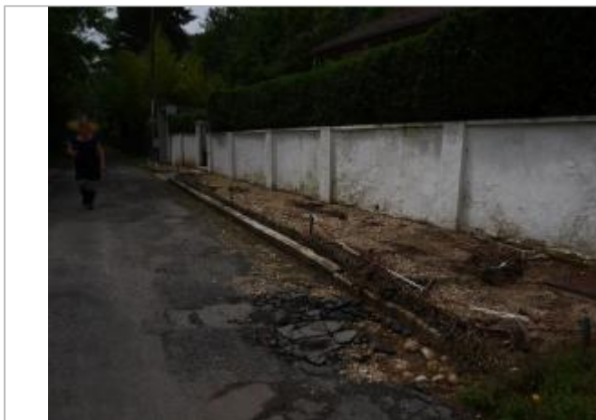
Vue du site - Auteur : DRIEE IDF
