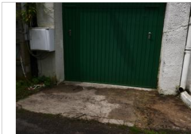
Vue du repère - Auteur : DRIEE IDF
