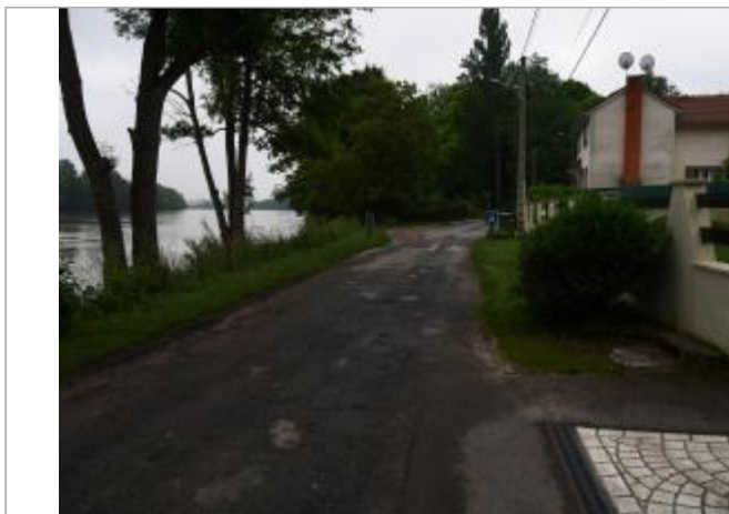
Vue du site - Auteur : DRIEE IDF
