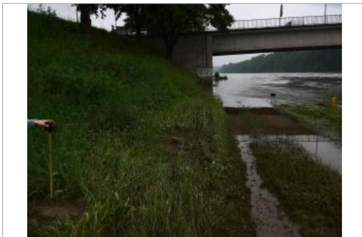
Vue du site - Auteur : DRIEE IDF
