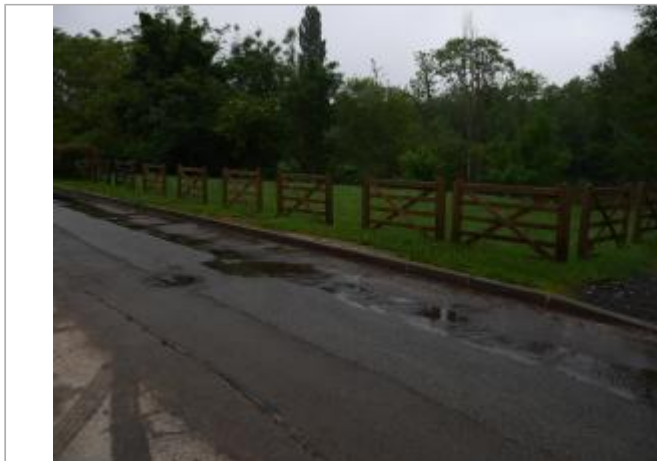
Vue du site - Auteur : DRIEE IDF
