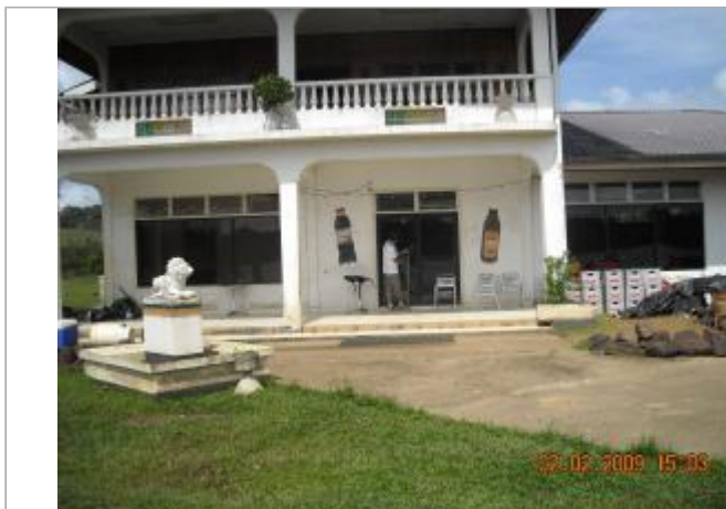
Vue globale du bâtiment
