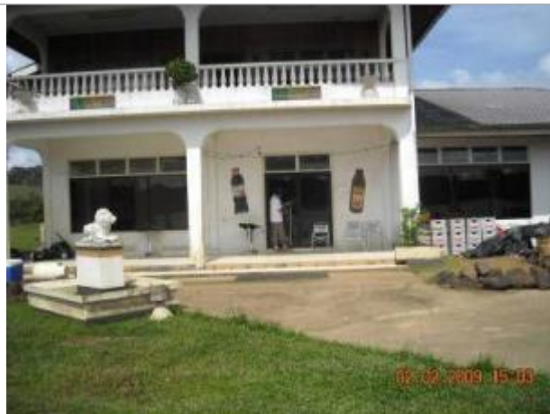
Vue globale du bâtiment
