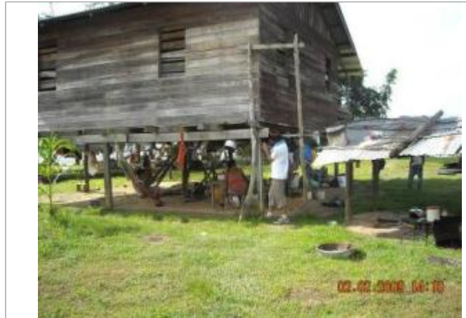
Vue globale du bâtiment
