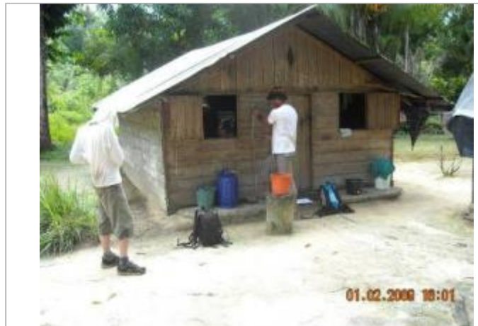
Vue globale du bâtiment
