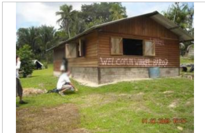
Vue globale du bâtiment
