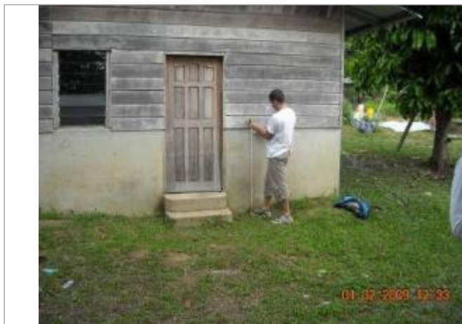
Vue globale du bâtiment
