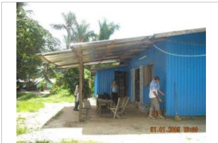
Vue globale du bâtiment
