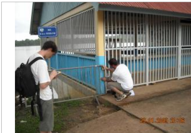
Vue globale du bâtiment
