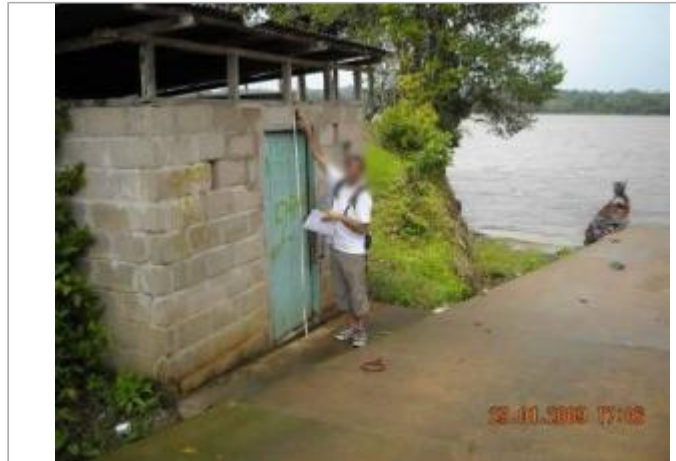
Vue globale du bâtiment
