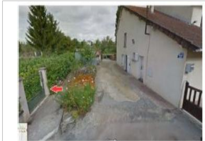
Vue globale du bâtiment
